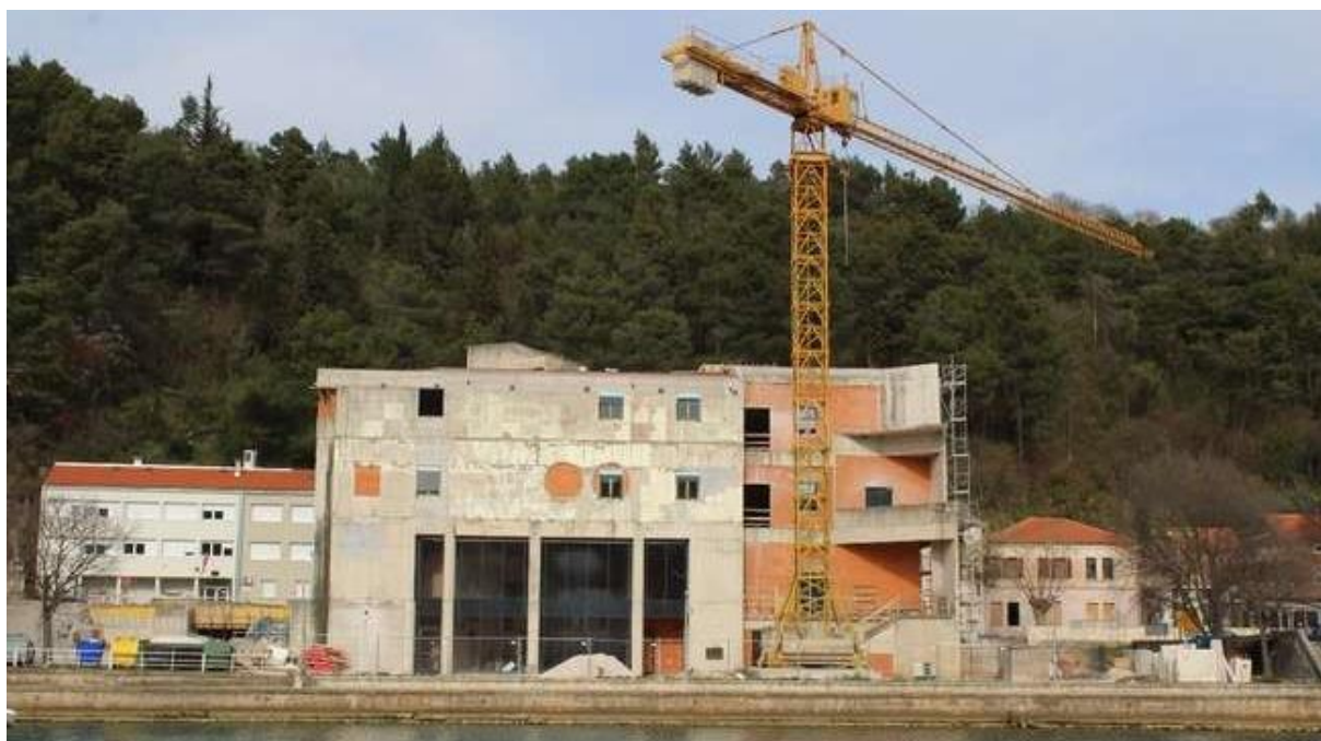
Slika 6: Preuređenje stare robne kuće
