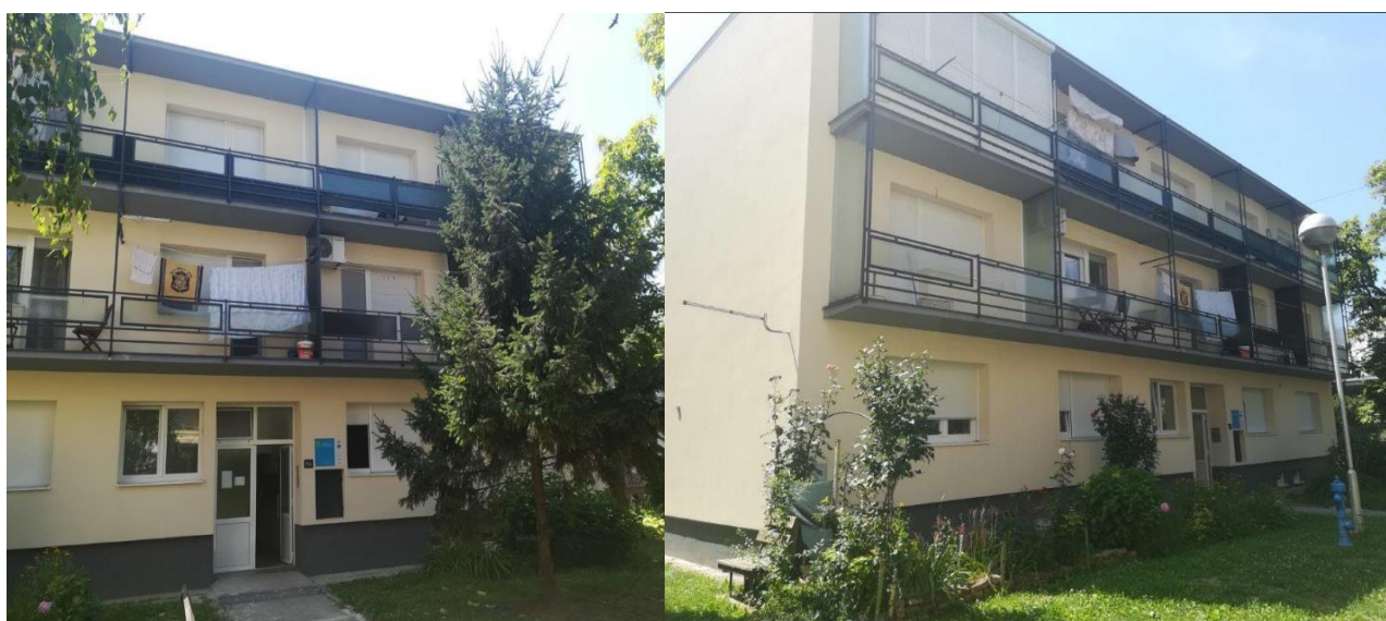
Slika 11. Prikaz pročelja zgrade prije obnove (gornja slika) te poslije obnove (dvije donje slike)
