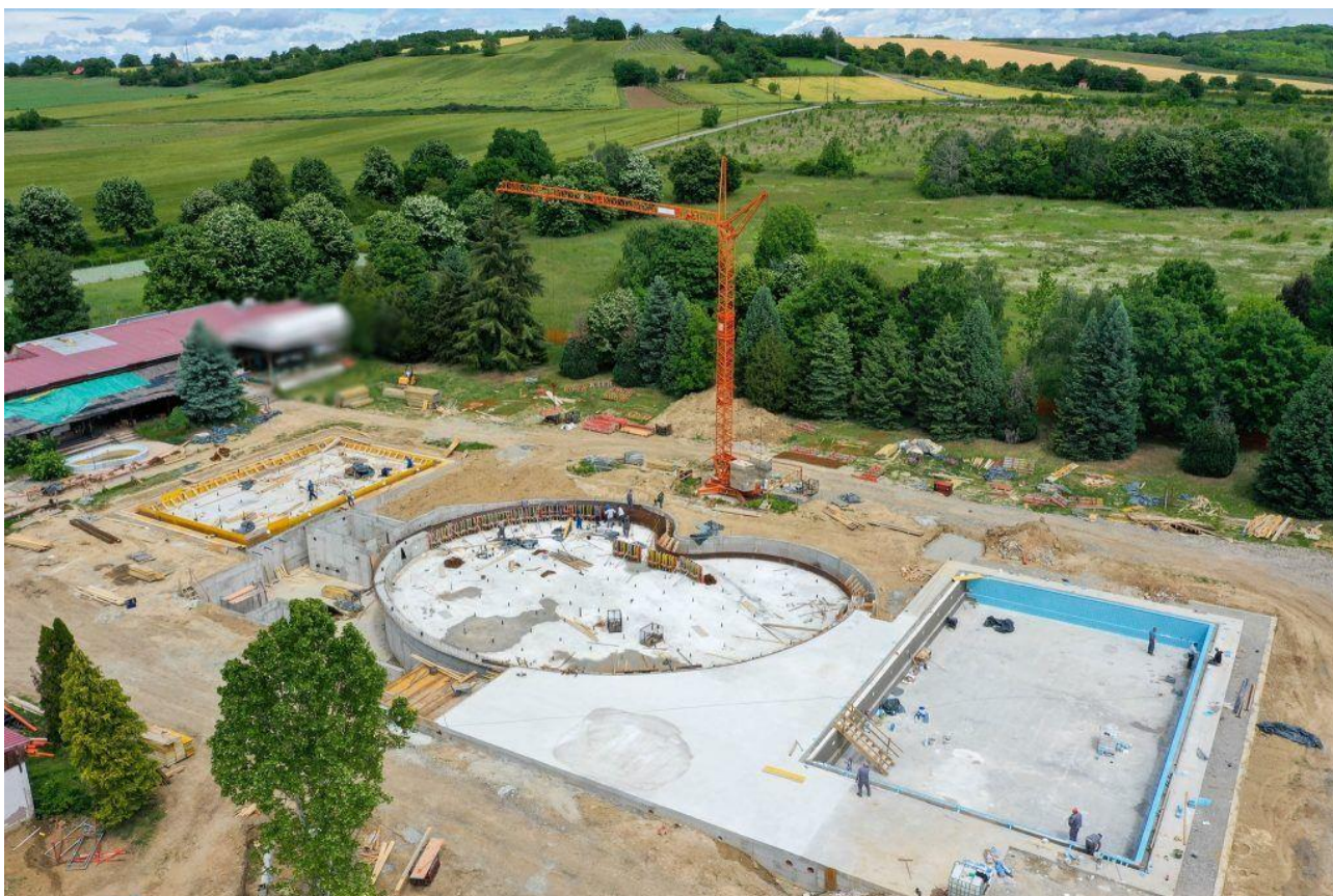
Slika 6. Početak radova izgradnje gradskih bazena u Belom Manastiru
