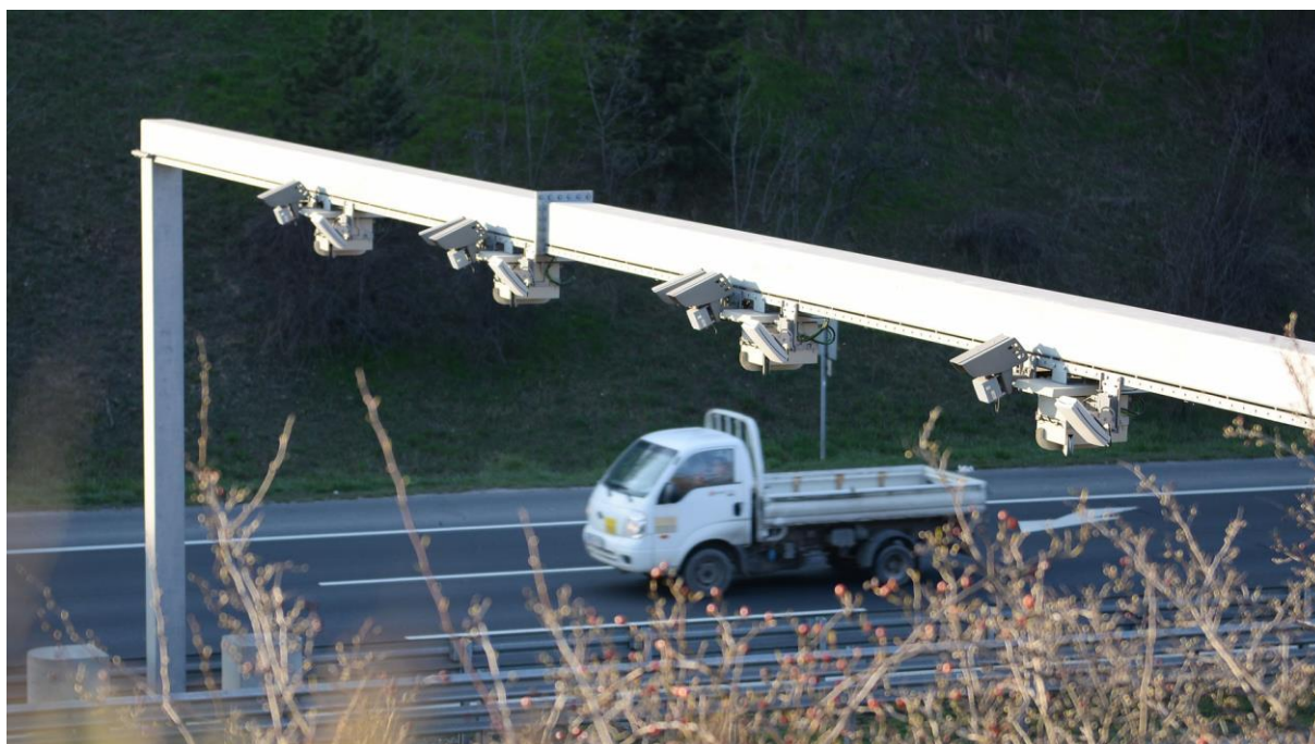
Slika 7 Prometni stup sa sustavom kamera za provjeru registracijskih oznaka na autocesti M7 kod Erda u Mađarskoj
