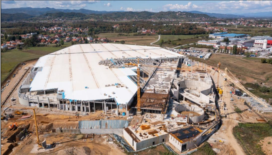
Slika 4 Proces izgradnje Rimac Campus
