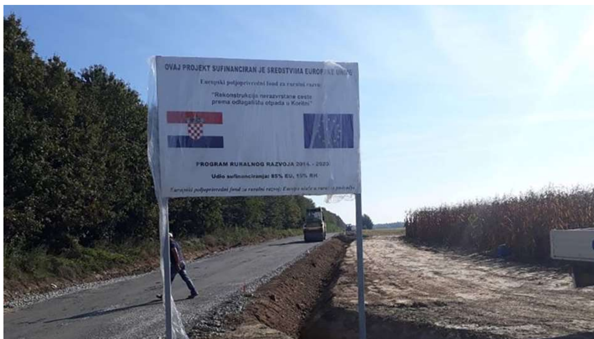
Slika 5: Rekonstrukcija nerazvrstane ceste prema odlagalištu otpada u Koritni, preuzeto sa: www.semeljci.hr
