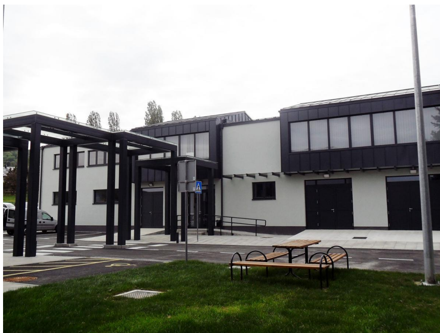
Slika 13 Mali Tehnopolis Samobor
