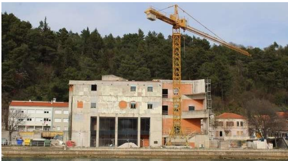
Slika 6: Preuređenje stare robne kuće
