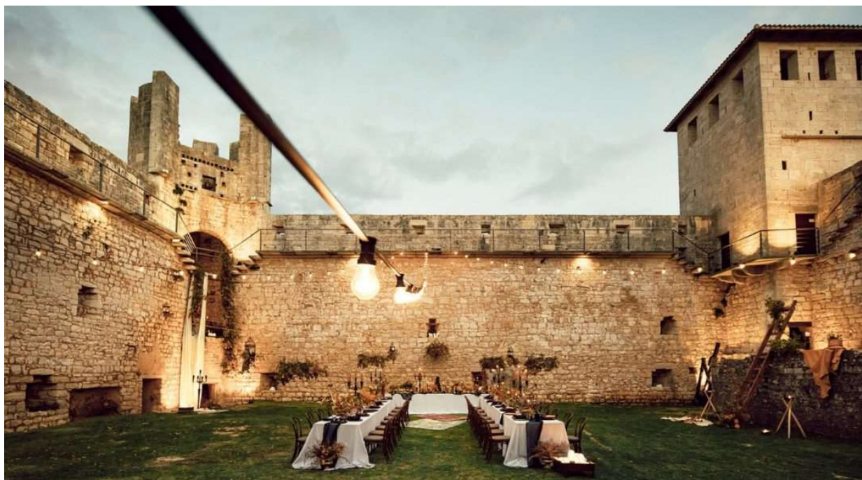
Slika 16, primjer baštinske lokacije, Kaštel Morosini-Grimani Svetvinčenat
