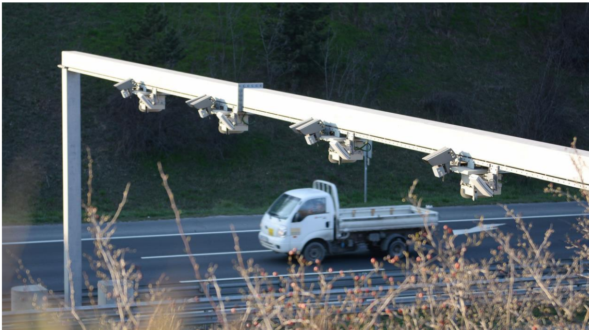
Slika 7 Prometni stup sa sustavom kamera za provjeru registracijskih oznaka na autocesti M7 kod Erda u Mađarskoj
