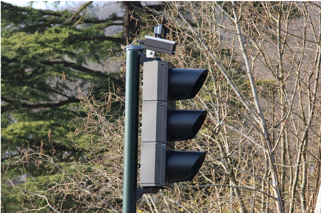
Slika 13 Kamera za snimanje prolaska kroz crveno svjetlo, postavljena iznad semafora
