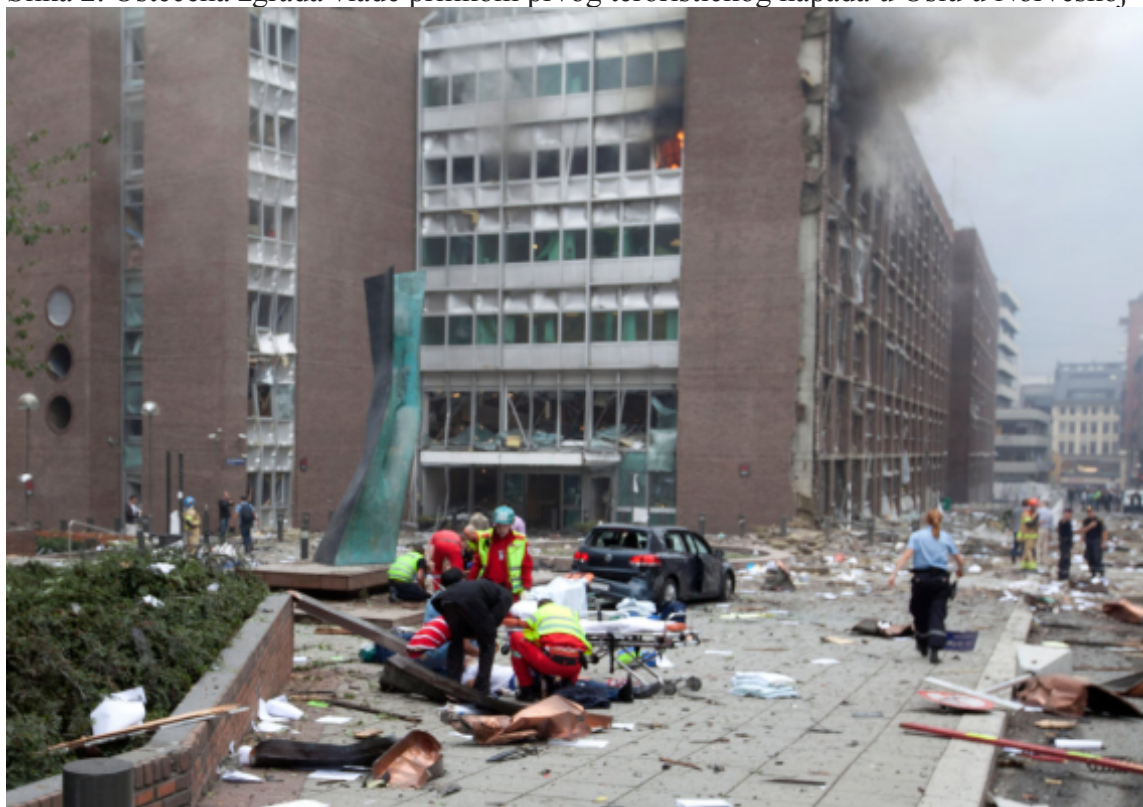
Slika 2. Oštećena zgrada vlade prilikom prvog terorističkog napada u Oslu u Norveškoj
